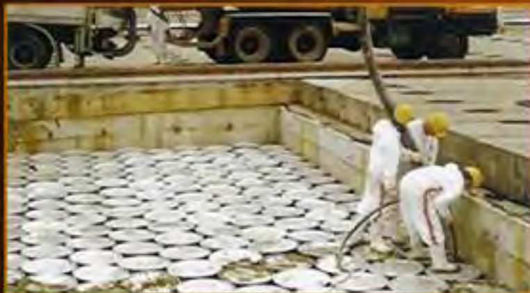
A tárolótér végleges lezárása
